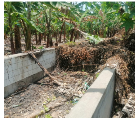
Estado actual de empacadoras de banano en Zarumilla.
